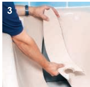
3 Aufschneiden der alten Wanne.
