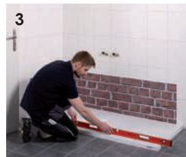
Vorarbeiten für die Duschwannenmontage.
