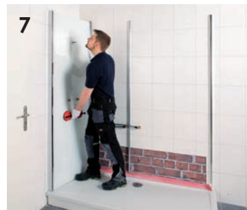
7 Einbringen der Wandverkleidung.
