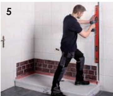
5 Installation der Vorwandmontage.
