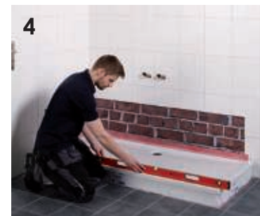
Montage der neuen Duschwanne.
