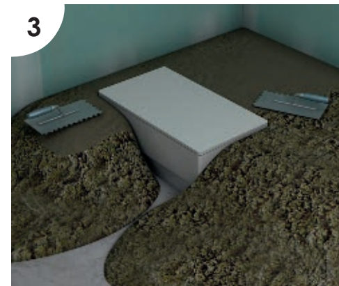
3 EINBRINGEN DES ESTRICHS
