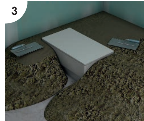
3 EINBRINGEN DES ESTRICHS
