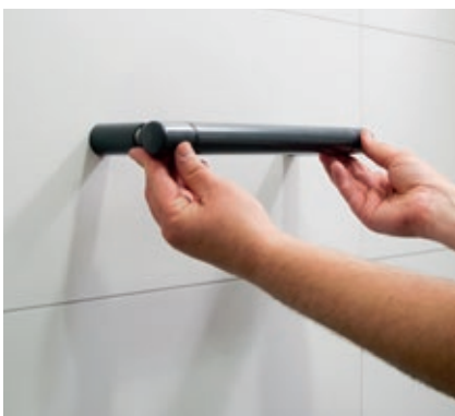
Aufsetzen des Griffrohrs auf die zwei montierten Anschlussstücke.
