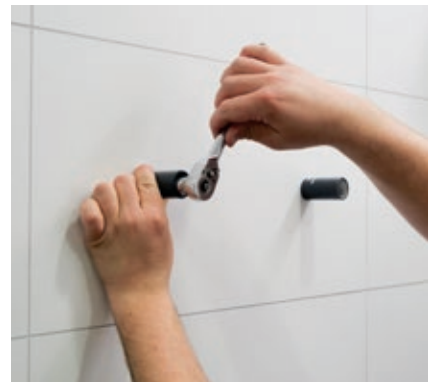
Zweites Anschlussstück montieren und ausrichten.
